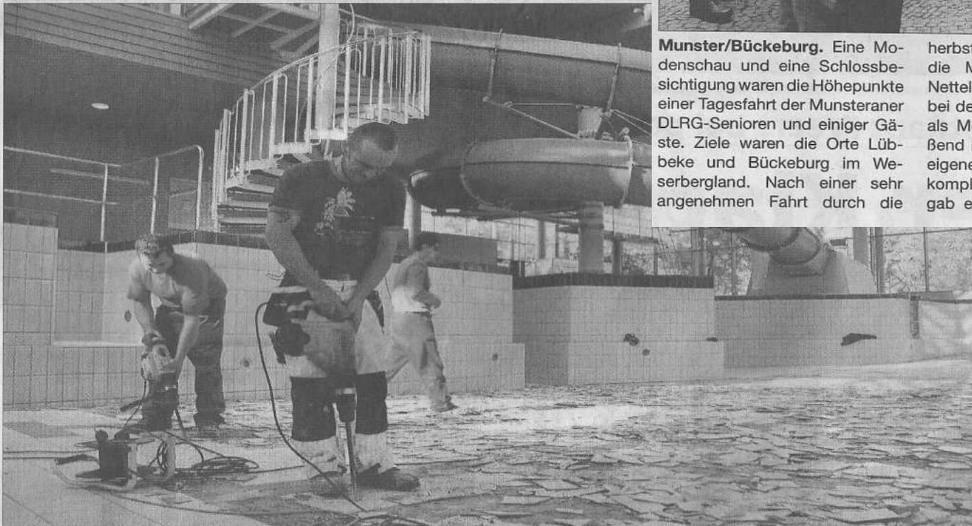
Presslufthammer statt Badehose: Im Allwetterbad in Munster wird das 500 Quadratmeter große Schwimmerbecken saniert. Dafür wird die Halle für Wochen geschlossen. Die Stadtwerke investieren rund 250.000 Euro. Dafür wird auch die Heizungsanlage modernisiert.
